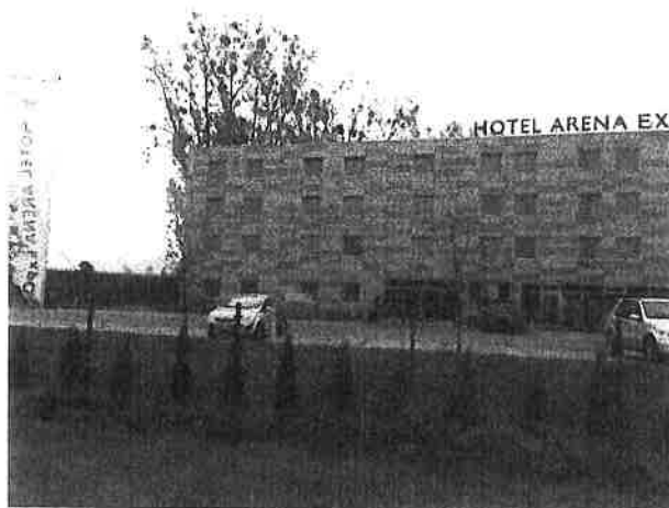
Fot. nr 1 Nieruchomość - widok ogólny
